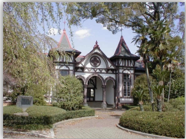
県立土浦第一高等学校 旧本館
